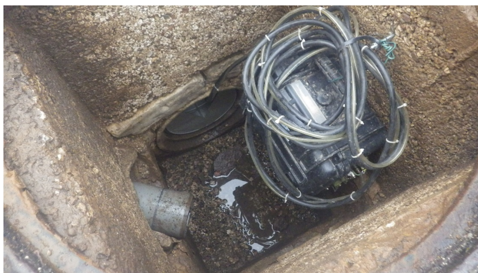
Figure 40 : Regard M9 équipé en nappe haute et nappe basse
