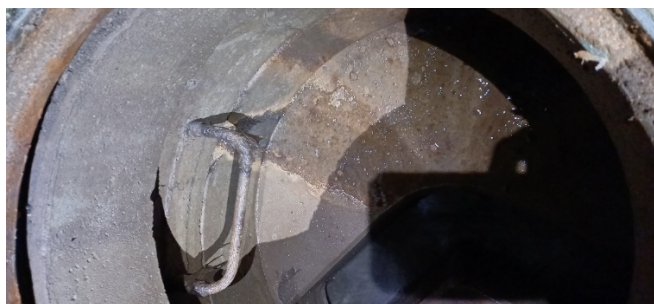
Figure 47 : Infiltrations d'eaux claires au sein d'un regard du réseau d'eaux usées (16/02/2024 et 21/03/2023)
