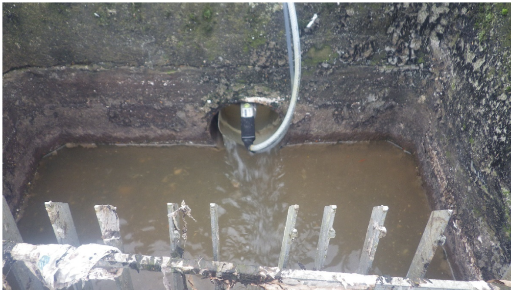
Figure 12 : Point M2 équipé en nappe haute
