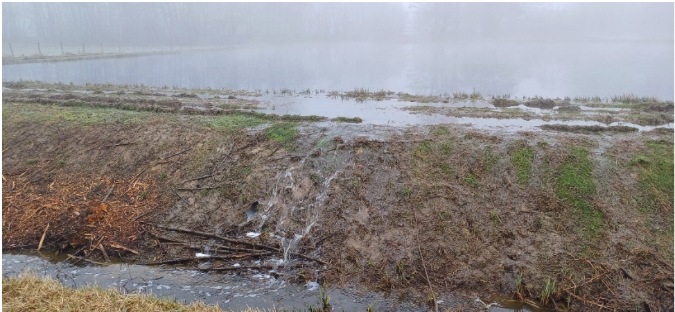
Figure 16 : Débordement de la 4 e lagune de la STEU d’Amagney (29/02/2024)
