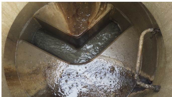
Figure 47 : Infiltrations d'eaux claires au sein d'un regard du réseau d'eaux usées (16/02/2024 et 21/03/2023)
